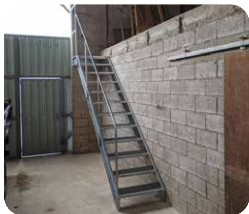
La Commune a sécurisé l'accès à l'étage par la pose d'un escalier et d'un garde corps en lieu et place d'une échelle en bois dangereuse. Ce travail a été réalisé par la SARL GLG Guillemain de Courlans.
