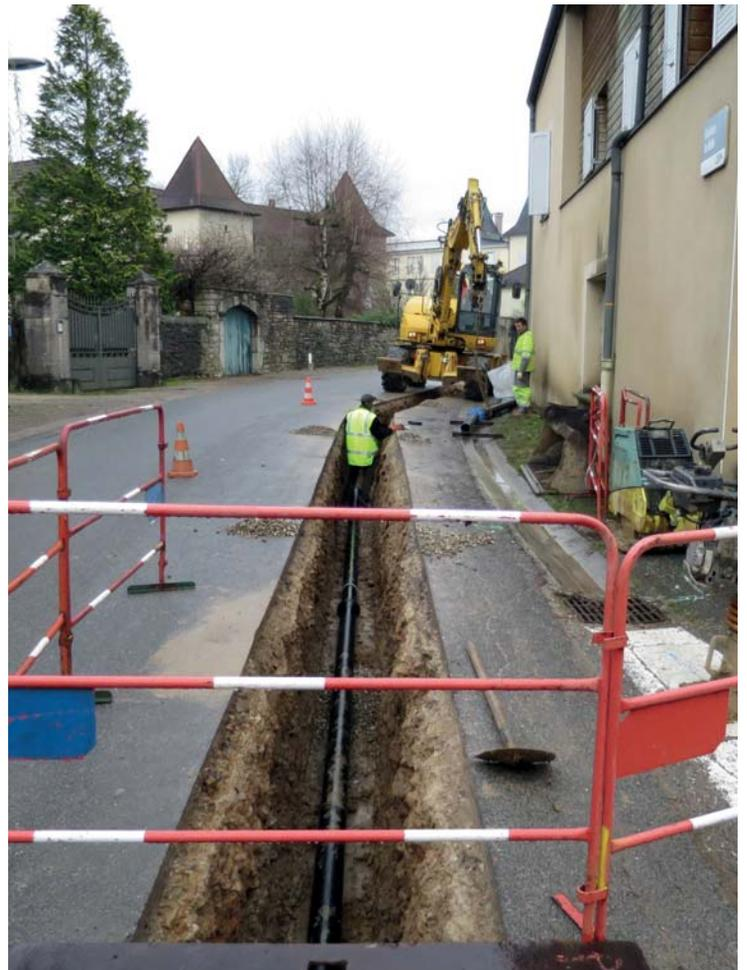
En parallèle le SIEA (syndicat des eaux de Bletterans) réalise le remplacement des canalisations d'eau potable (d'amiante-ciment en fonte) et contrôle caméra des canalisations d'eau pluviale.
