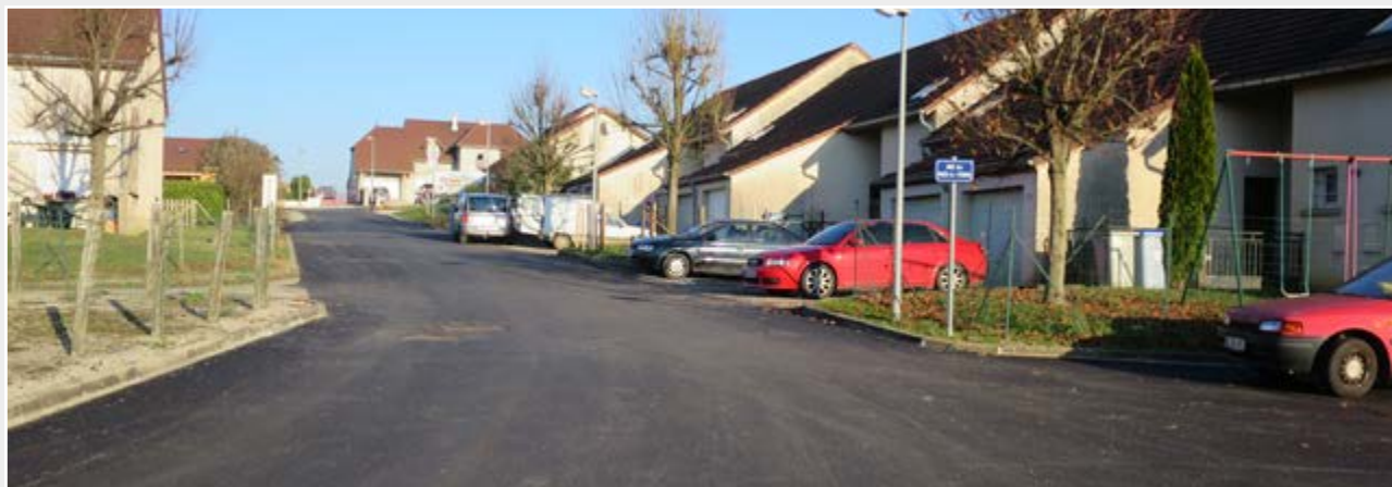
Mise en œuvre d'un enrobé sur la rue des Prés de l'Etang pour un montant de 16 349 euros HT.
